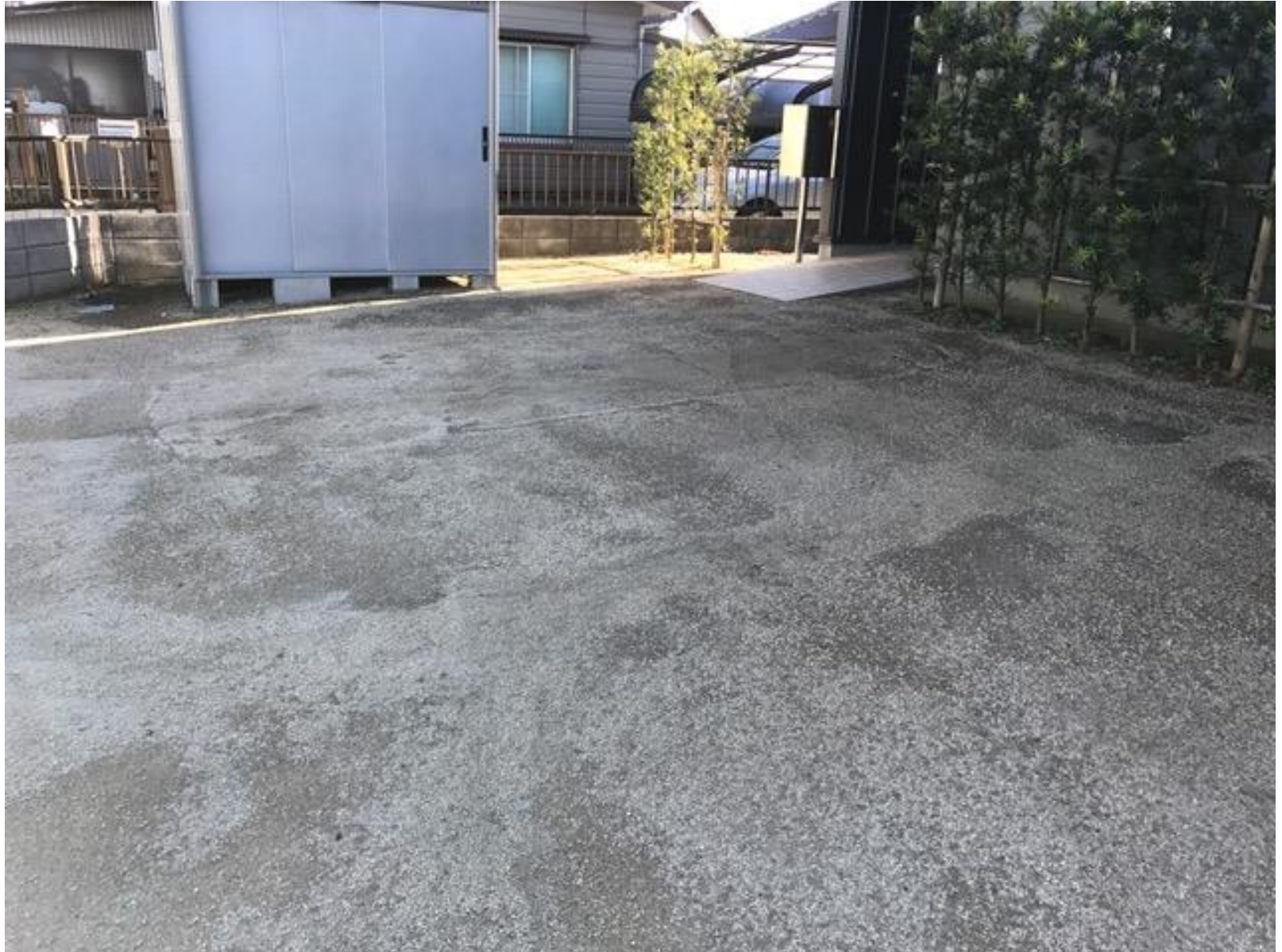
施工後4年経過後の舗装状況
