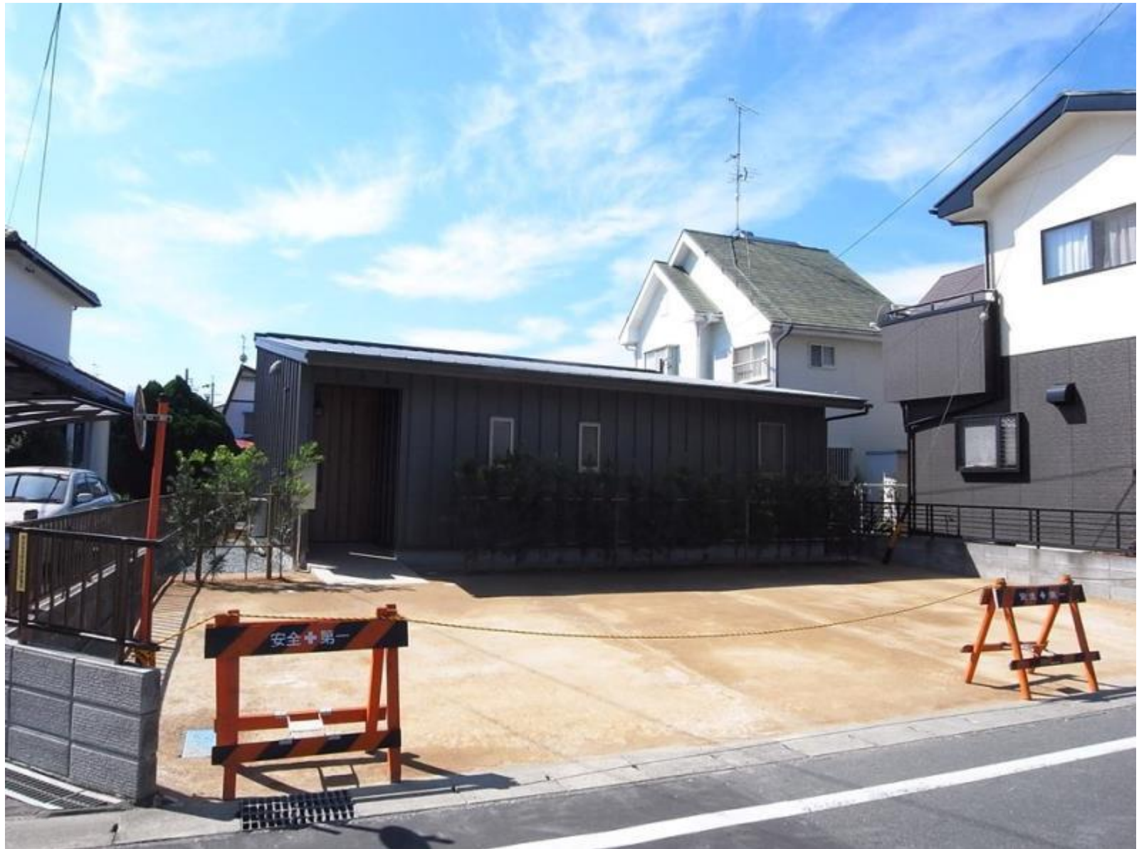
舗設完了 その1
