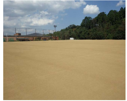
立命館宇治中学校・高等学校 第2グラウンド改修工事
