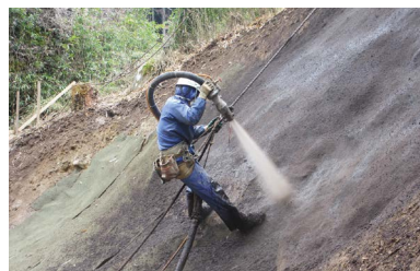
のり面の腐植酸を散布する工事
