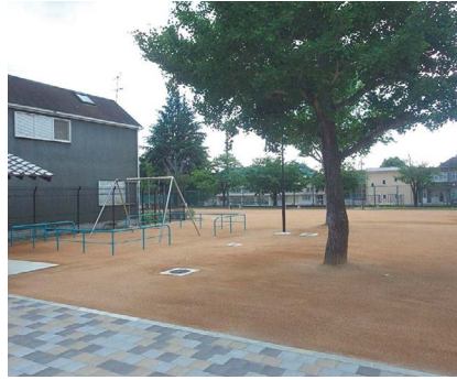
北白川公園再整備工事
