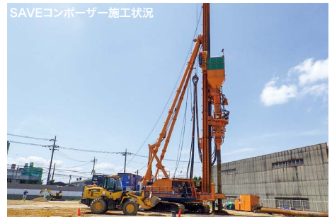
SAVEコンポーザー施工状況
