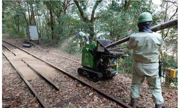
豊田市の鉄道廃線後の跡地です。地元のウォーキングコースになっているので、段差解消のために周辺の竹を活用し、チップを敷き均しています。
