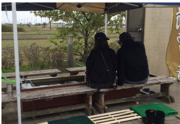
移動式タイプの足湯給湯システムの様子
