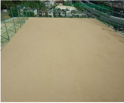
大阪青凌中学校・高等学校島本学舎 建設工事
