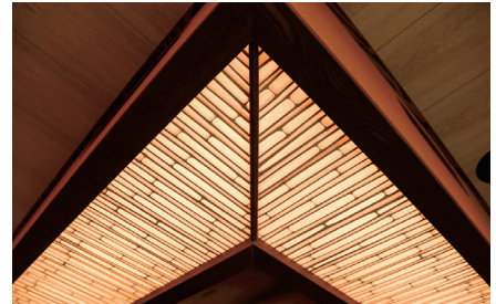
設計施工：株式会社三角屋 竹の断面を生かした桁割加工
