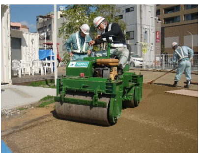
⑧一次転圧
