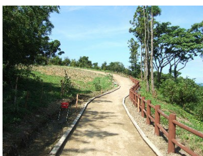
⑧型枠の設置
