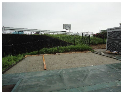
①型枠設置
