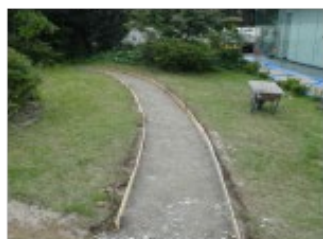
(j) 型枠設置完了
