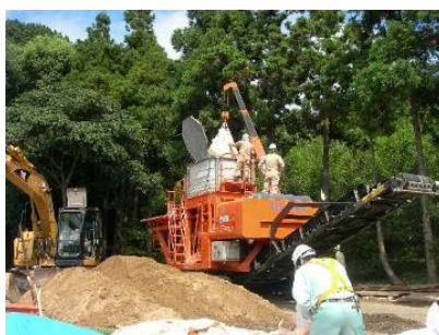
⑤固化材の投入
