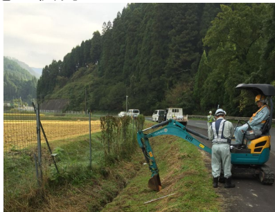
①掘削・床付け
