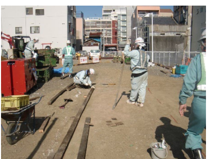
⑤型枠設置
