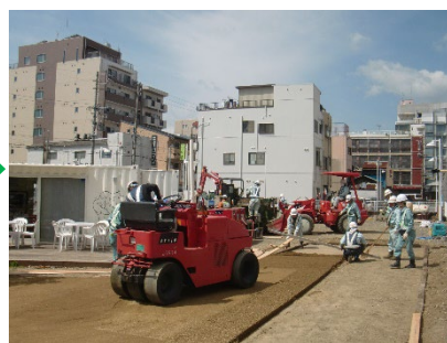
⑨二次転圧
