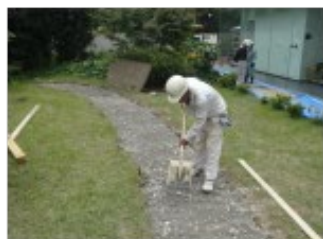
(f) 路盤敷均し
