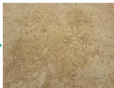
⑧仕上がり面
