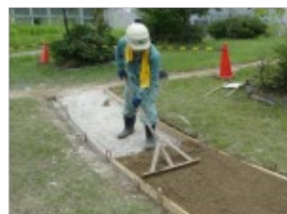
(l) 表層敷均し
