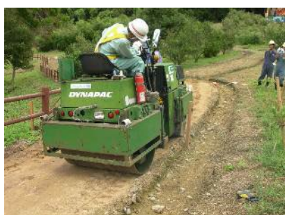
⑦路面の整地
