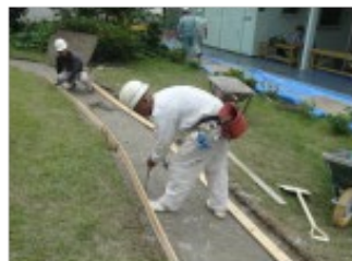
(i) 型枠設置
