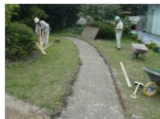
(h) 路盤完了
