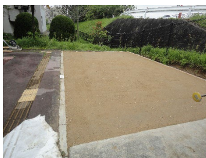
⑧仕上がり
