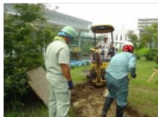
(b) 掘削状況
