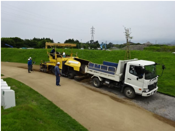
(c) 機械敷均し①
