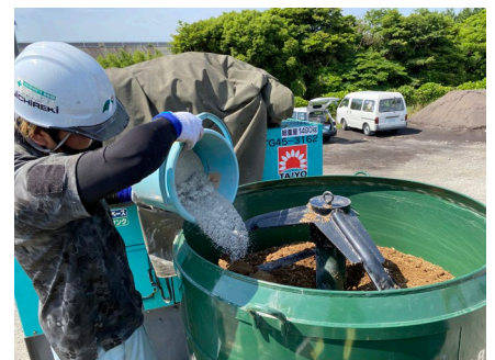
③ 主固化材投入
