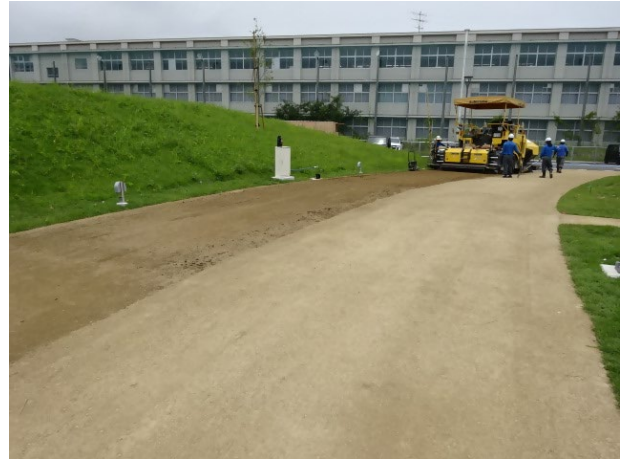
(d) 人力敷均し②
