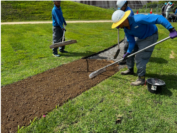
(a) 人力敷均し①
