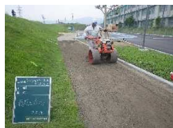
④敷均し整正
