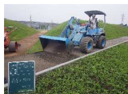
③小運搬・敷均し
