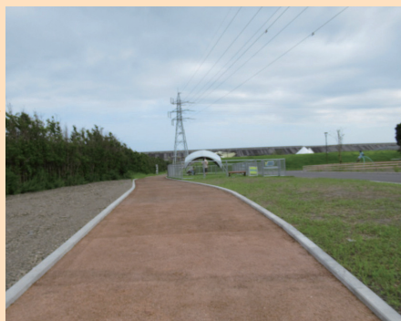
竹チップ舗装施工事例「静岡市トライアルパーク蒲原」
