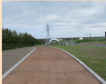
竹チップ舗装施工事例「静岡市トライアルパーク蒲原」
