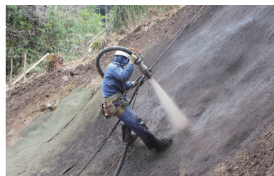
のり面の腐植酸を散布する工事
