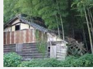
家屋を倒壊させている様子
