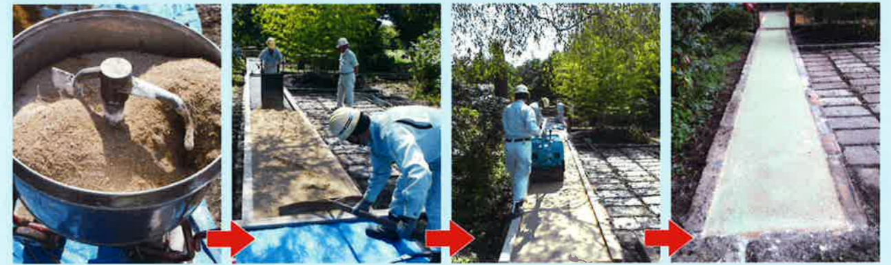
①材料混合(モルタルミキサー)
