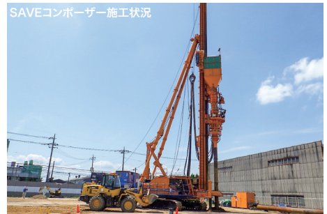
SAVEコンポーザー施工状況
